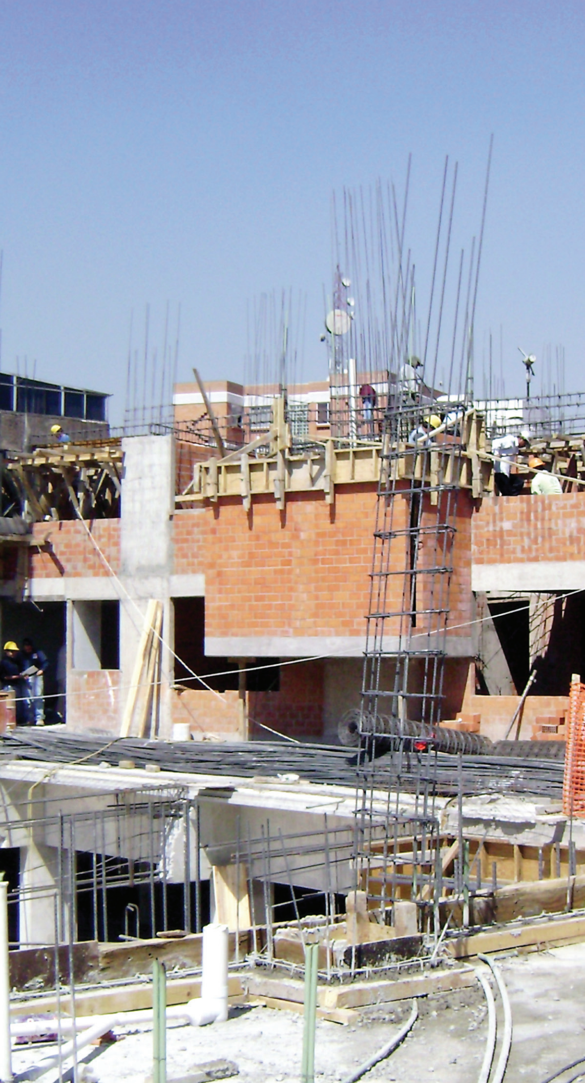
Conjunto habitacional en construcción, México, D.F.
