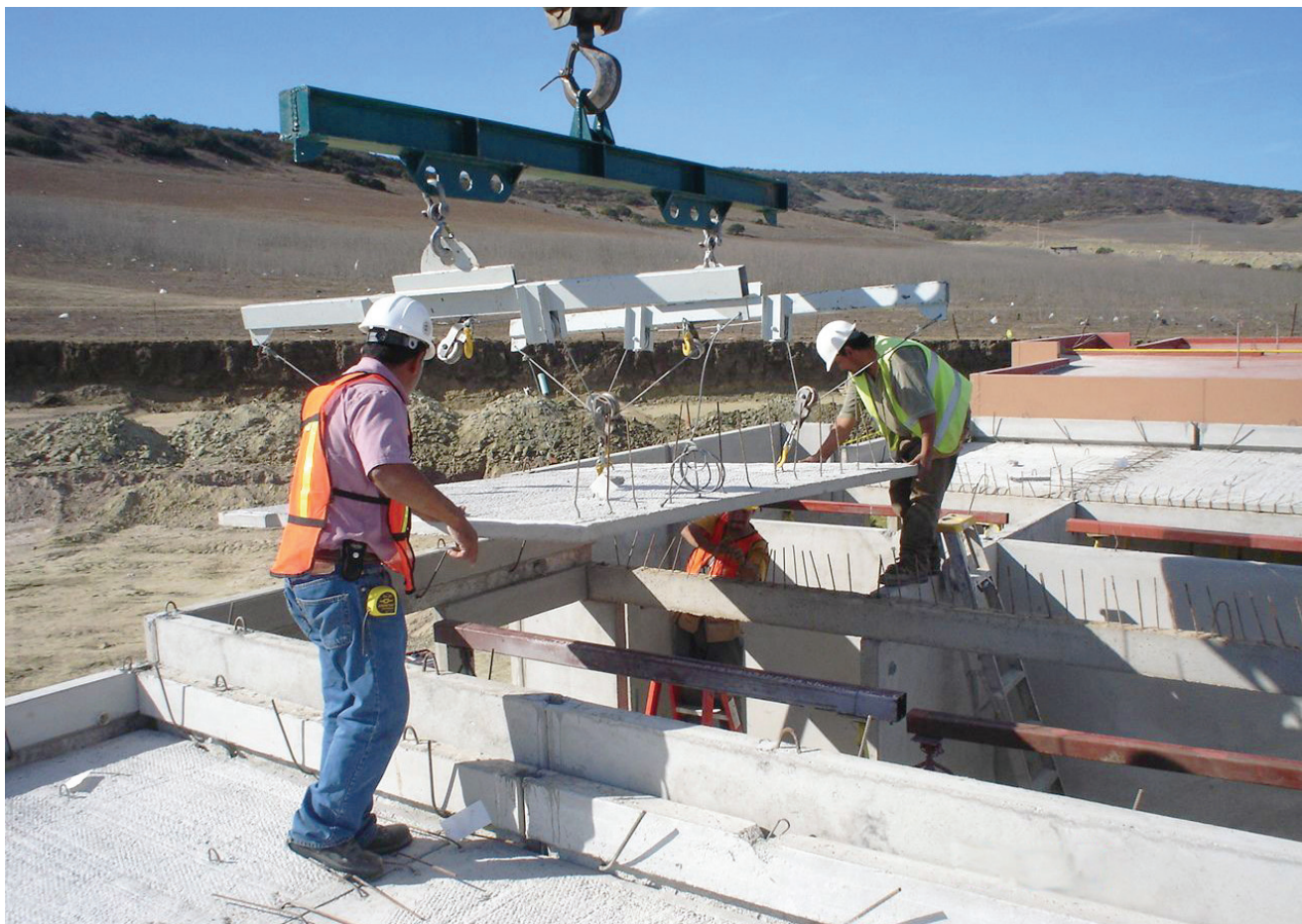
Construcción, Hacienda Las Delicias, Tijuana, Baja California Norte.
